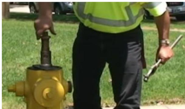
4. Assurez-vous d'ajuster la tige supérieure au niveau de la base de l'orifice situé dans l'écrou en bronze et la clé en acier
