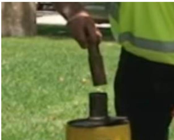
3. Visser l'écrou en bronze sur la tige supérieure à l'aide de la clé à borne d'incendie jusqu'à la fermeture complète de la borne
