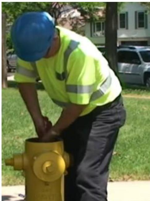
Un deuxième technicien procède à la réouverture de la vanne d'isolement et ce à un rythme très lent d'environ 1 à 1,5 tour au maximum.
